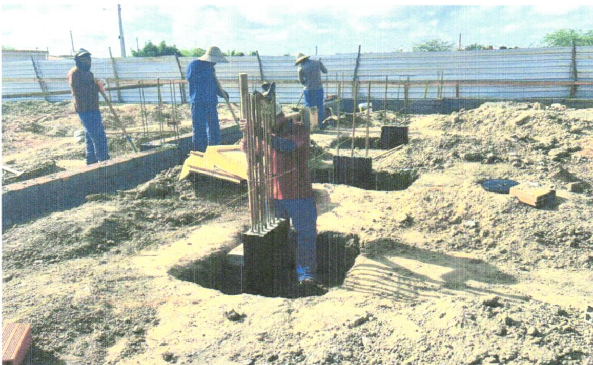
FOTO 12 – Regularização e compactação do fundo de valas
