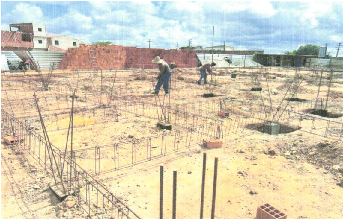
FOTO 36 – Armação de aço CA-50 Ø 10mm; incluso fornecimento, corte, dobra e colocação
