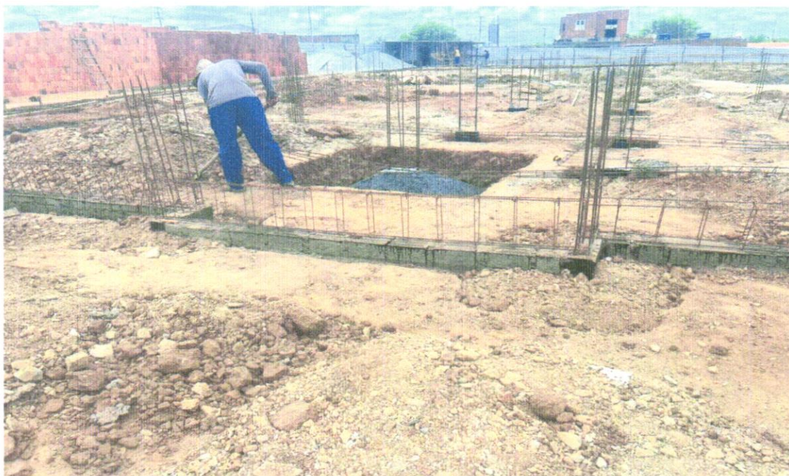
FOTO 06 – ATERRO MANUAL DE VALAS COM SOLO ARGILO-ARENOSO E COMPACTAÇÃO MECANIZADA. AF_05/2016
