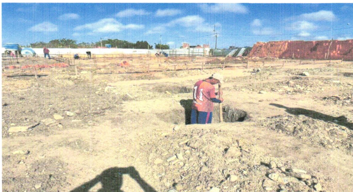
FOTO 10 – Regularização e compactação do fundo de valas
