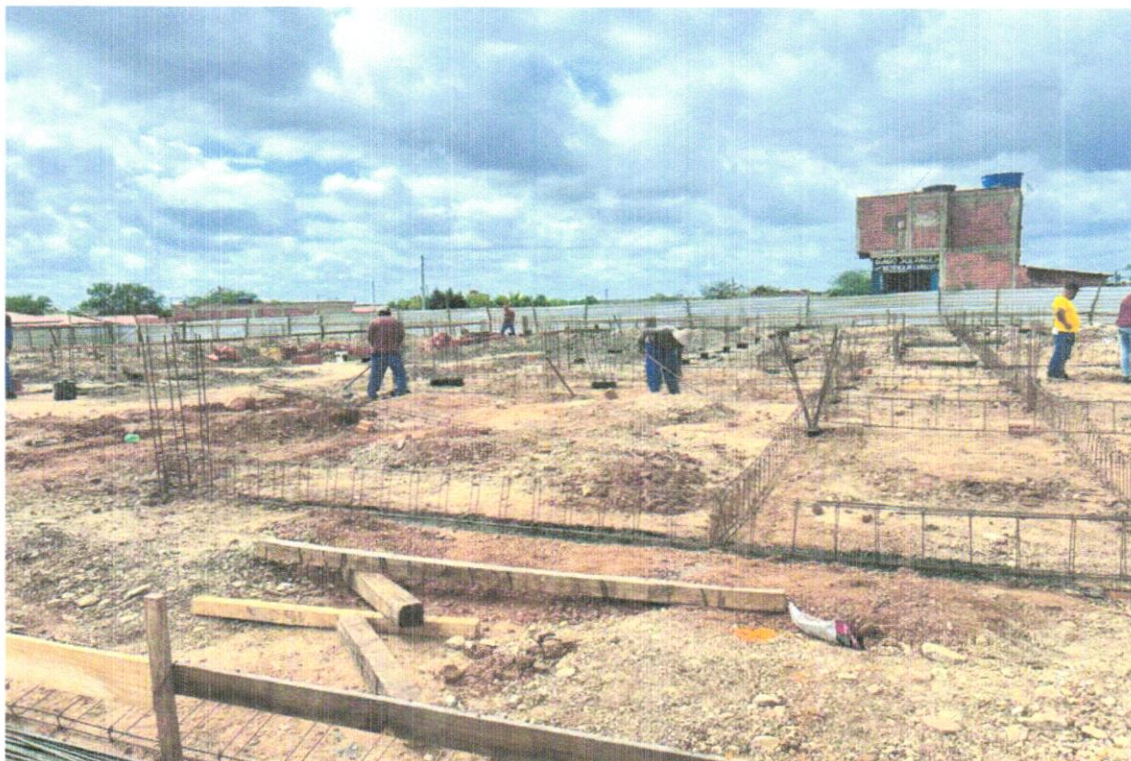
FOTO 10 – Regularização e compactação do fundo de valas
