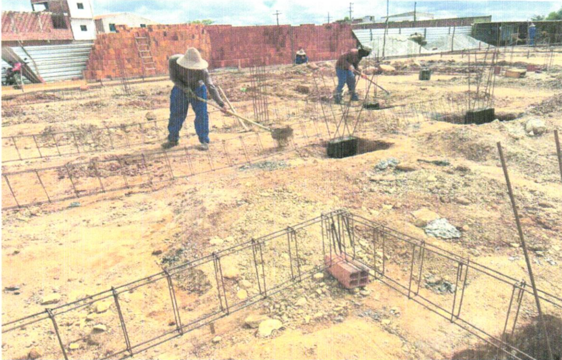
FOTO 08 – ATERRO MANUAL DE VALAS COM SOLO ARGILO-ARENOSO E COMPACTAÇÃO MECANIZADA. AF_05/2016
