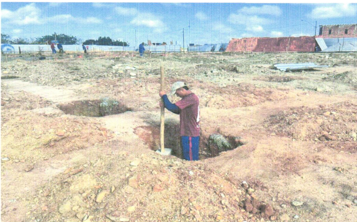
FOTO 12 – Regularização e compactação do fundo de valas
