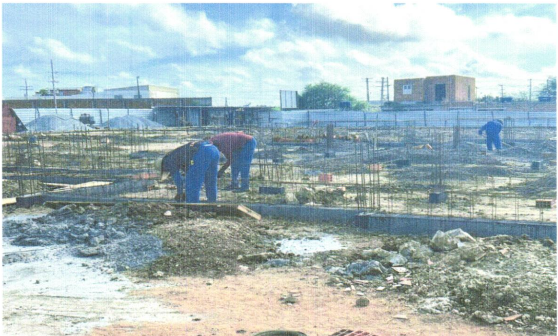
FOTO 36 – Armação de aço CA-50 Ø 10mm; incluso fornecimento, corte, dobra e colocação
