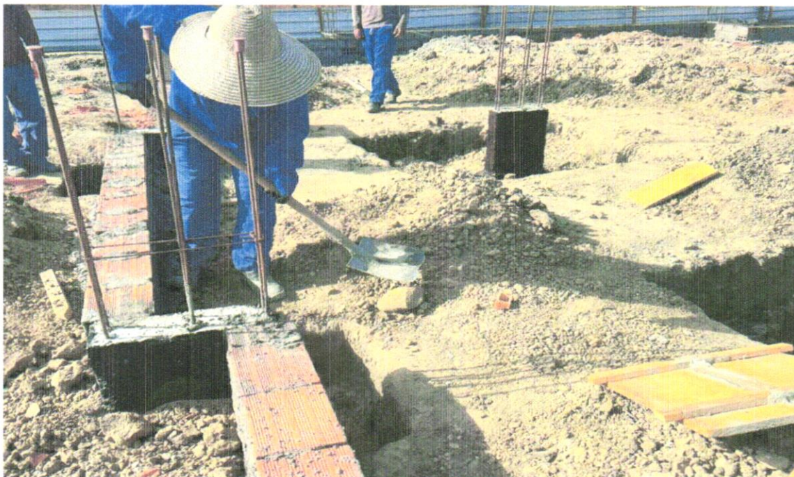
FOTO 06 – ATERRO MANUAL DE VALAS COM SOLO ARGILO-ARENOSO E COMPACTAÇÃO MECANIZADA. AF_05/2016
